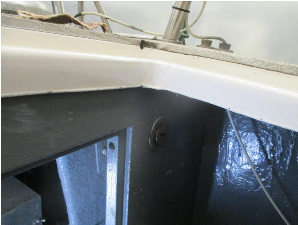
Nieuwe plaats vulopening olietankje schroefas smering en afdichting
