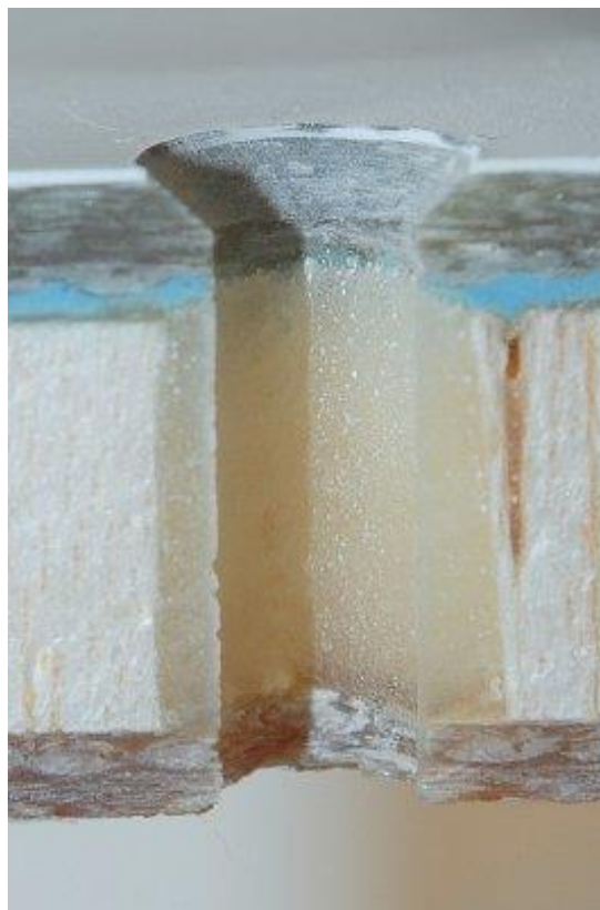
Afb. 6. Een opgepot gat en opnieuw geboord
