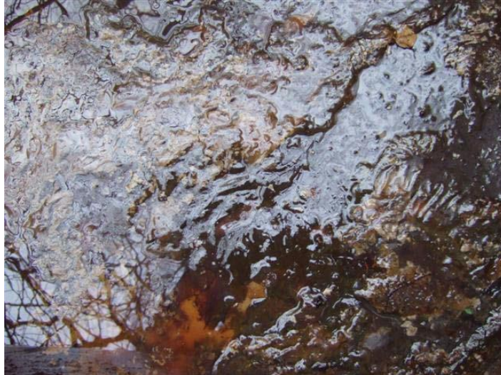
Slijmerige substantie op tankwand en bodem door micro organismen
