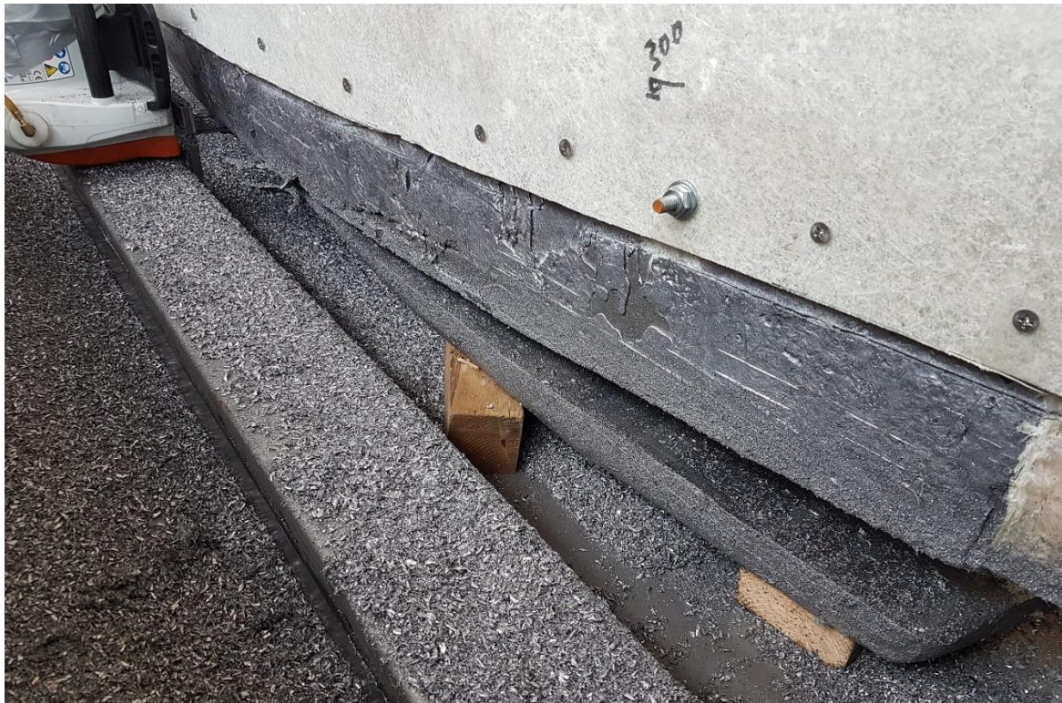
De kettingzaag aan het werk en de afgezaagde plak lood.
