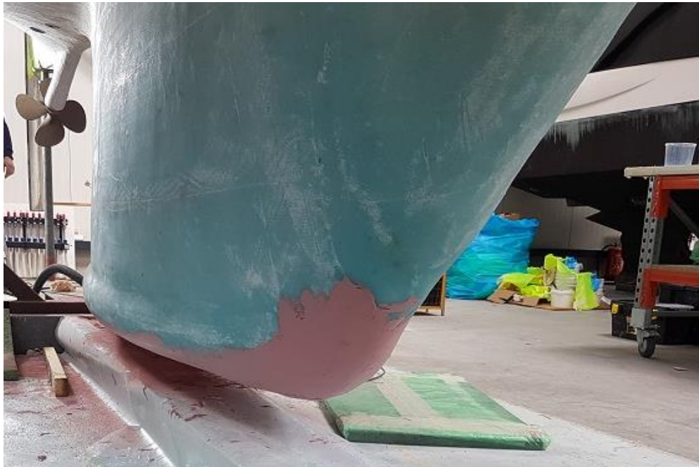
Geplamuurd en matten aangebracht, verbreding onderste deel van de kiel is goed te zien
