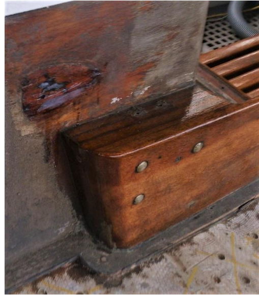
12. Met drie slotbouten wordt de klos weer 'dicht getrokken'
