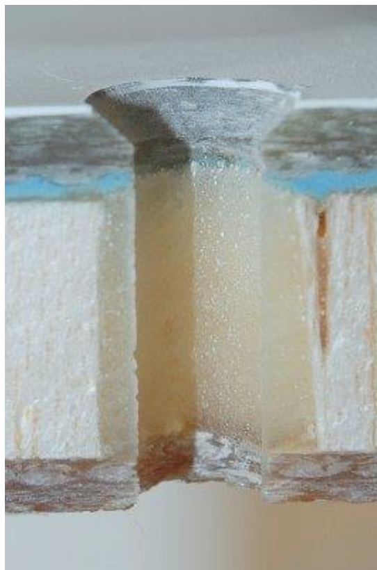
Afb. 6. Een opgepot gat en opnieuw geboord
