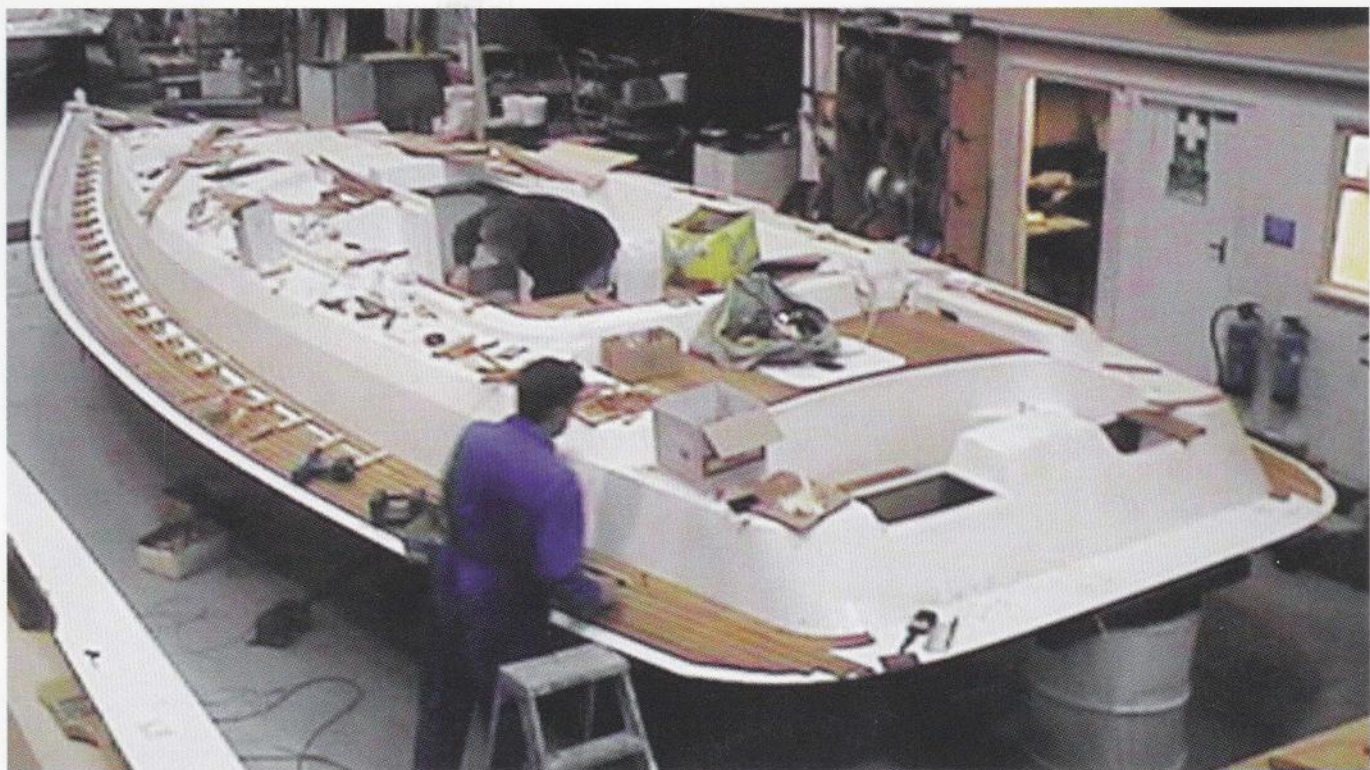
Deck im Bau
