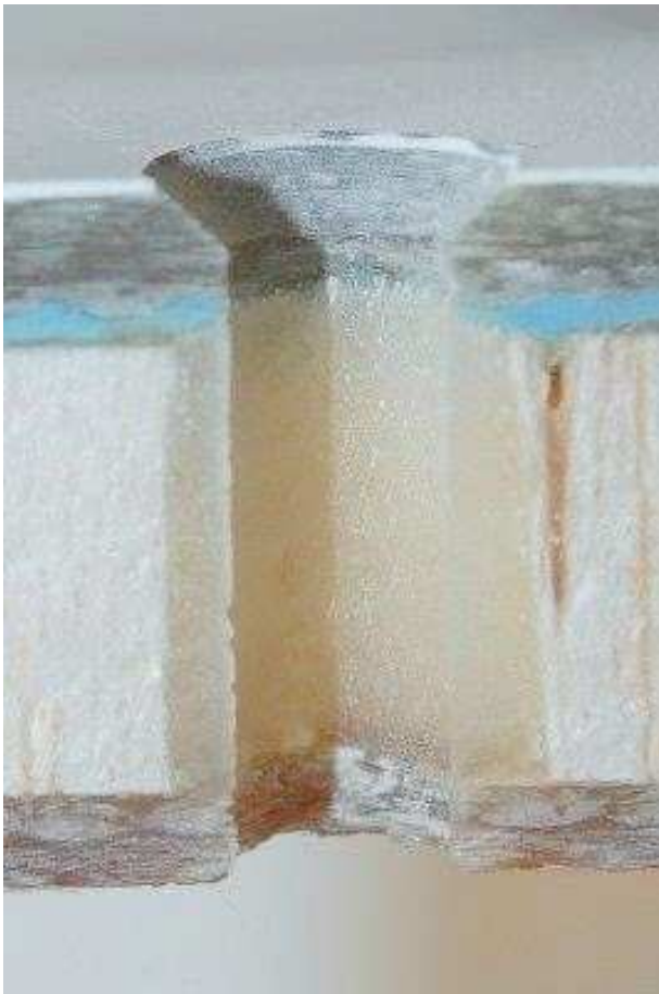
Afb. 6. Een opgepot gat en opnieuw geboord
