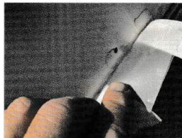
Hier zijn luchtbelletjes tussen gekropen. Geen probleem, gewoon nabehandelen.
