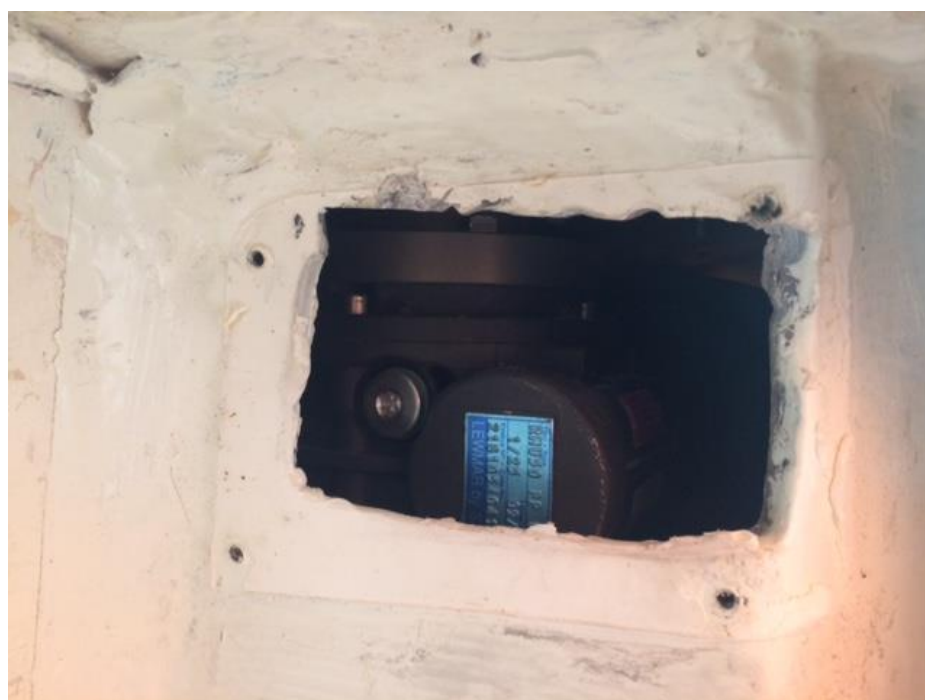
Inspectiegat voor bereikbaarheid motor
