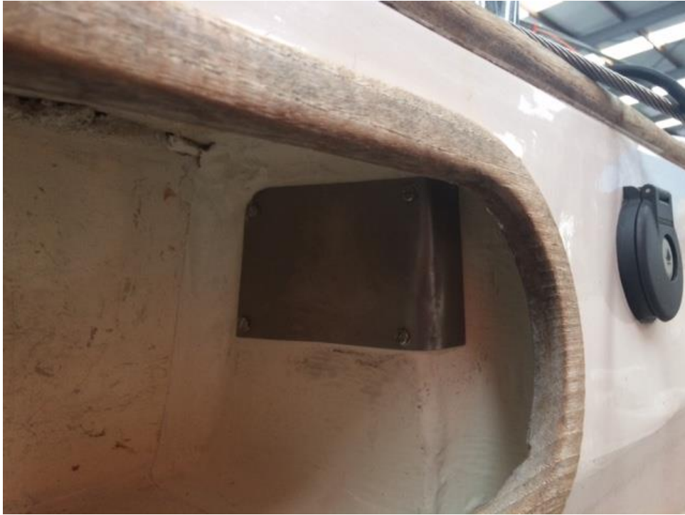
Nieuwe inspectieluikje met bedieningsknop
